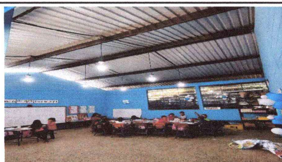
Foto 2: Sustitucion de cableado y lamparas
