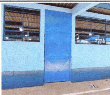
Foto 3: mantenimiento de puerta de metal, remocion de oxido y cambio de chapa, pintura.
