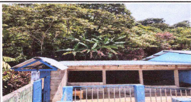
Foto1: Sustitucion de pared de tabla por block de cocina
