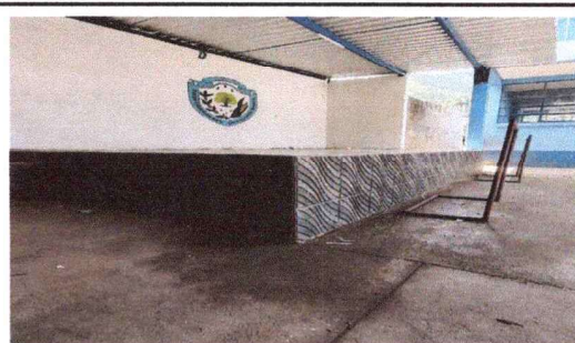
Foto 6: Remozamiento de escenario con estructura de metal, lamina y piso de granito.
