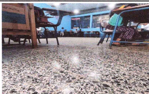
Foto 5: Sustitucion de piso de cemento por piso de granito
