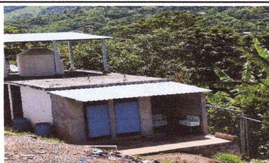
Foto 4: Remozamiento de bateria de baños, cubierta de lamina y puertas
